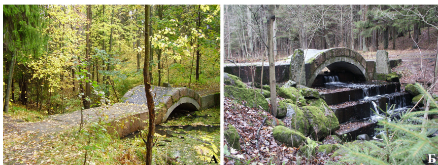
Илл. 12. Восстановленная в 1985–1987 гг. гранитная плотина-мостик (горбатый) восточного ручья. 12а—Верхний бьеф. 12б—Нижний бьеф. Фото 2008 г.
