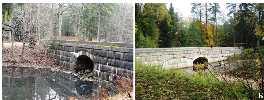
Илл. 14. Восстановленная гранитная плотина-мостик Верхнего пруда. 14а — Нижний бьеф. 14б — Верхний бьеф. Фото 2005 г.
