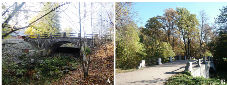
Илл. 18. Восстановленная в 1985–1987 гг. гранитная плотина-мостик Оранжерейного пруда, с массивными тумбами и чугунными перилами. 18а — Нижний бьеф. 18б — Верхний бьеф. Фото 2008 г.
