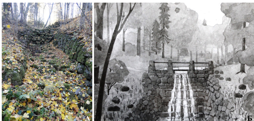
Илл. 20. Каменная плотина-мостик над каньоном западного ручья. Не восстанавливалась. 20а—Современный вид каньона с разрушающимися стенами каменной кладки из тесанных валунов. Фото 2005 г. 20б—Реставрационный проект плотины-мостика.(Ленгипроинжпроект, 1978).
