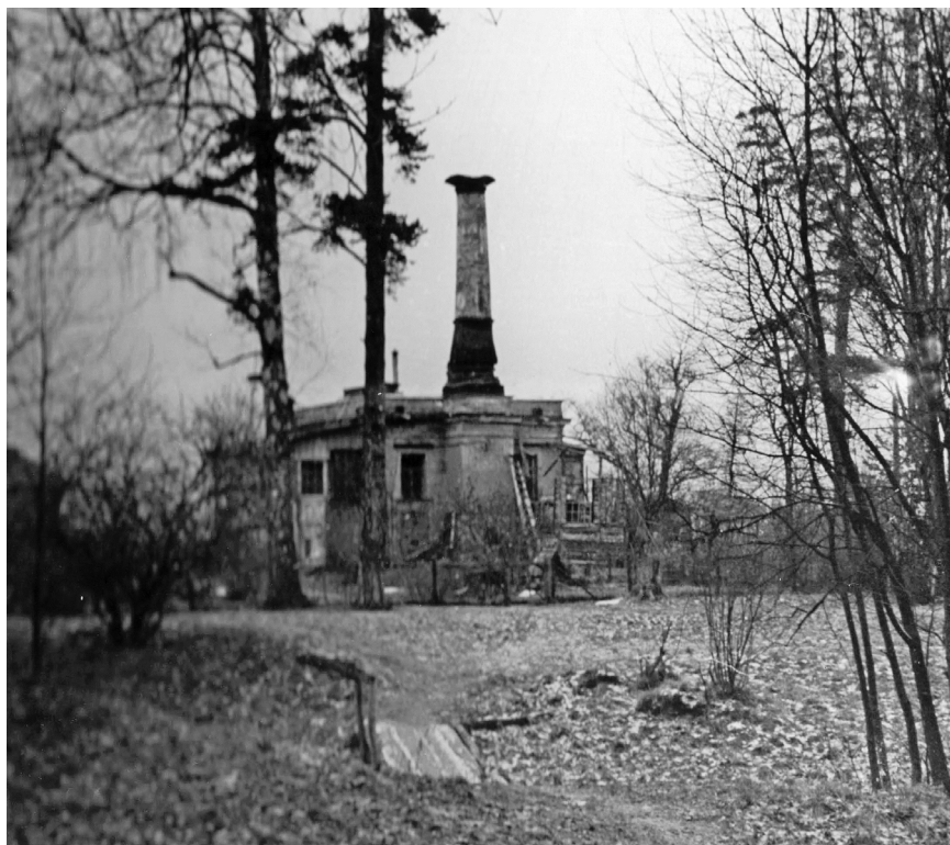
Илл. 7. Разрушенное здание водоподающей паровой машины у залива. Фото 1970-е гг.
