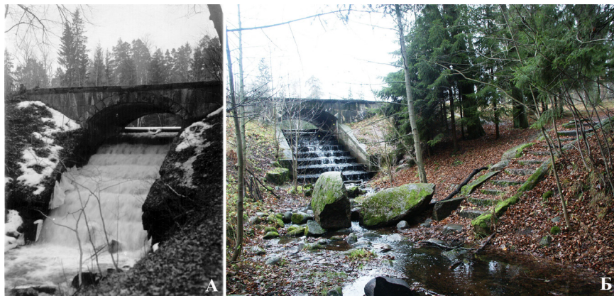
Илл. 10. Водосброс плотины Большого пруда, нижний бьеф. 10а— Водопад. Фото 1930-е гг. 10б— Восстановленная в 1985–1987 гг. плотина. Плиты водослива. Расколотый декоративный валун в форме раскрытых лепестков цветка. Каменная лесенка по склону оврага. Фото 2008 г
