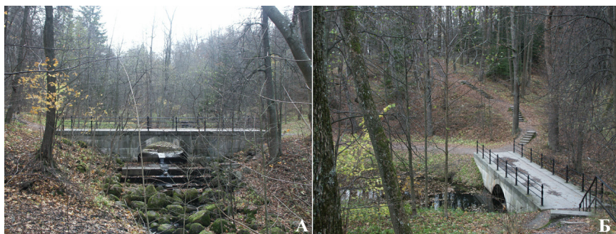
Илл. 13. Восстановленная в 1985–1987 гг. гранитная плотина-мостик с чугунными перилами восточного ручья под дворцом. 13а — Нижний бьеф. 13б — Верхний бьеф. Фото 2008 г.
