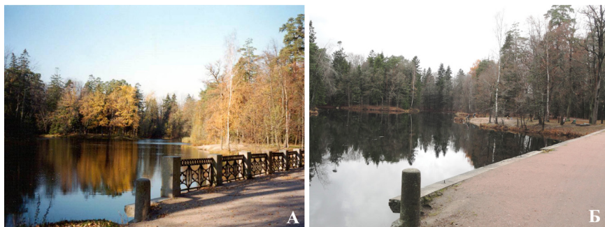
Илл. 9. Восточная часть плотины Большого пруда: 9а— До разрушения ограды. Фото 1999 г. 9б— После разрушения ограды. Фото 2008 г.
